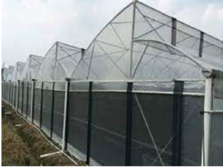
شکل (c) 8.2.6.1: دانت دار (Saw tooth)
